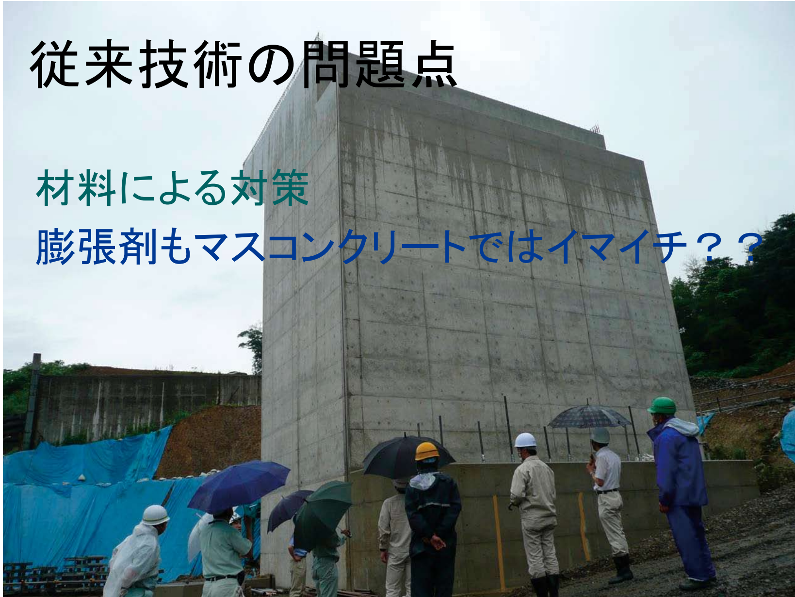
写真1 土木構造物のひび割れ調査
