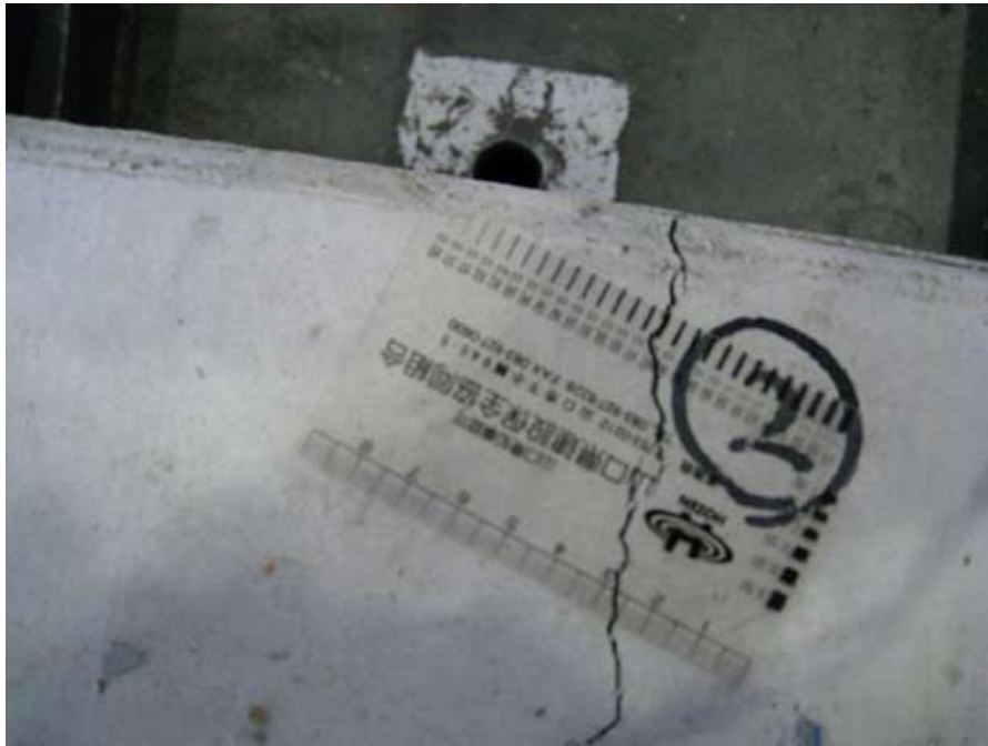
写真5 ノーマル(鋳無し)の 供試体のひび割れ (写真は、0.75mm幅)
