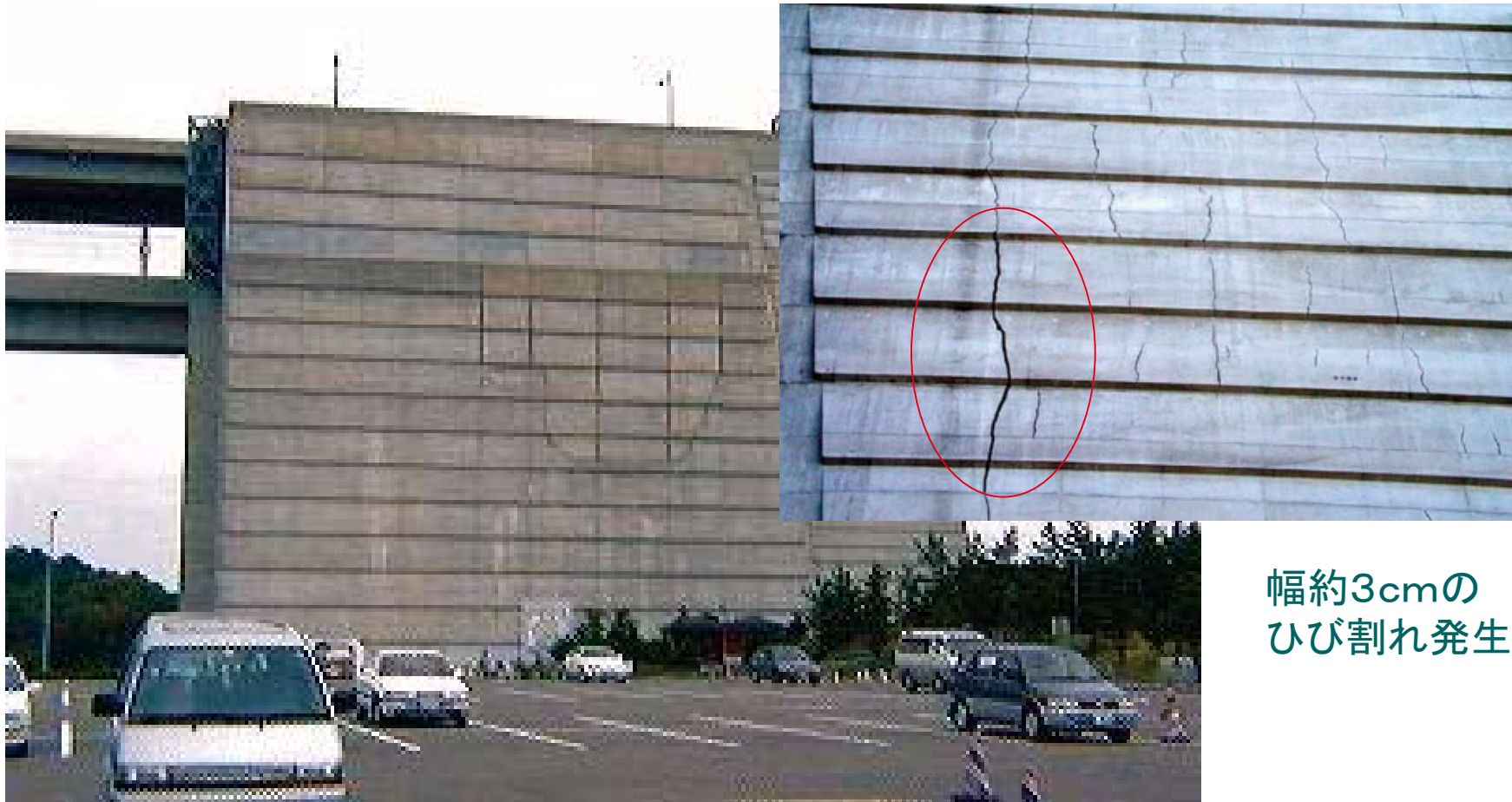
写真7 橋台のひび割れ
