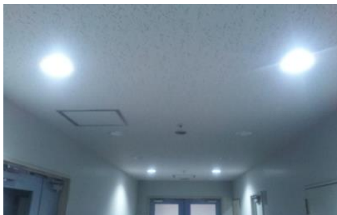
屋内無線LANに利用 (Li-Fi)
