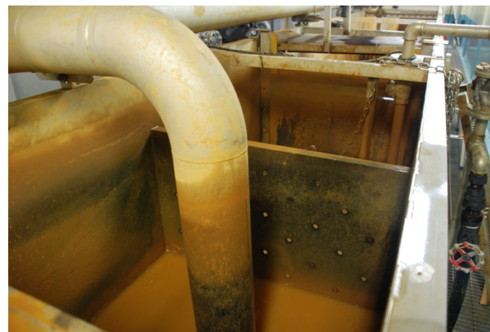
スラッジ貯留槽
