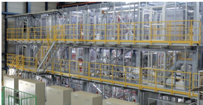
連続水素製造試験装置
