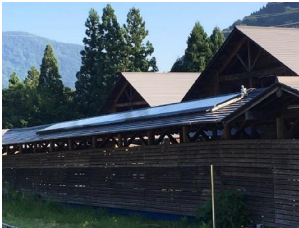
太陽光発電システム
