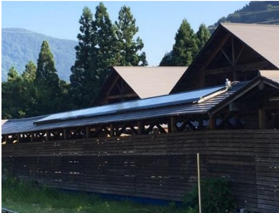
太陽光発電システム
