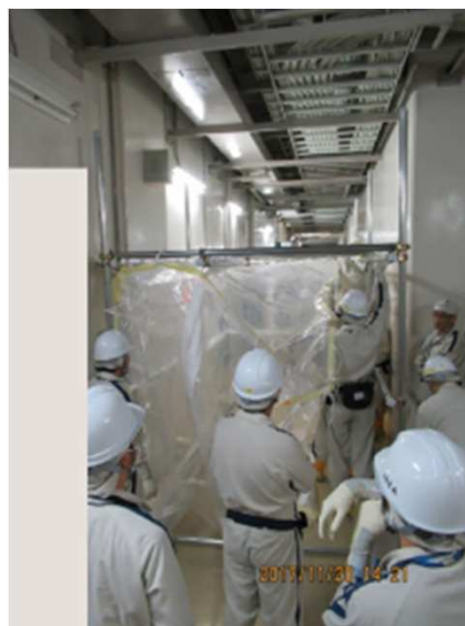
(5)テント取付け
