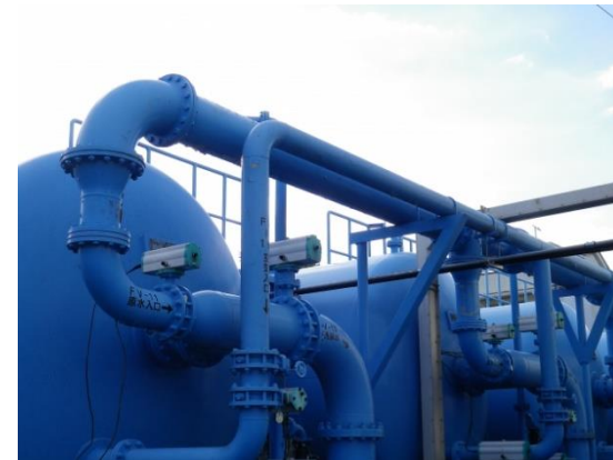
水処理施設 ポンプ
