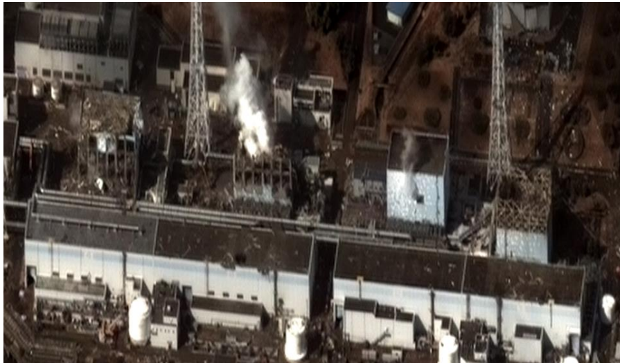
福島第一原子力発電所事故 (左から4号機、3号機、2号機、1号機)
