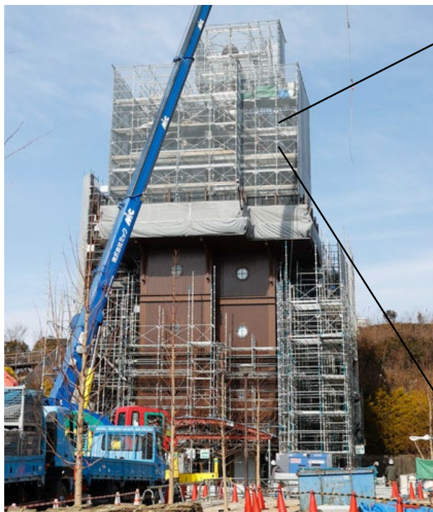
建設中の建物（@ジブリパーク）
