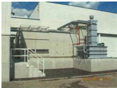
アンモニア冷却機 全景
