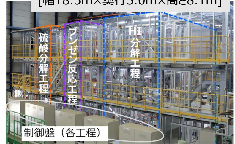
連続水素製造試験装置
