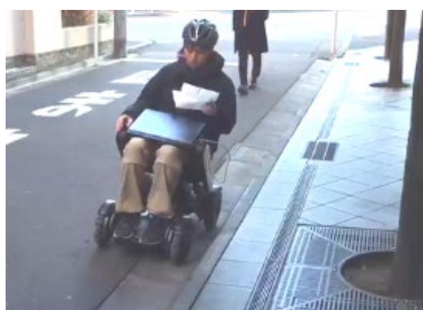
2. 横方向の段差
