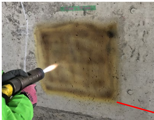
プラスチック溶射 (パウダーフレーム溶射)
