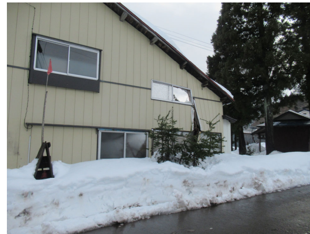
✓ 窓サッシの様子
