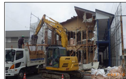
建物解体現場
