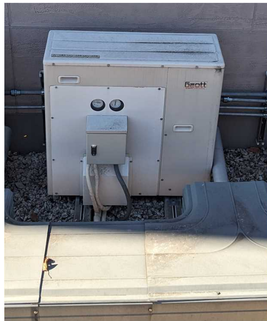
直接膨張方式地中熱ヒートポンプ (冷房6.8kW、暖房8.8kW)
