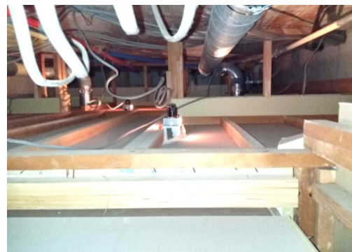
屋根裏の段差事例
